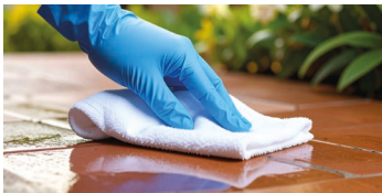
4. Rimozione del prodotto in eccesso
